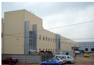
Логистический комплекс West Gate Logistic (I фаза) Житомирское направление, 9 км от Киева
