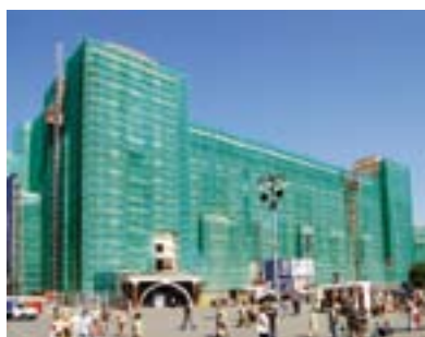
Реконструкция гостиницы «Москва», ул. Охотный ряд, 2
